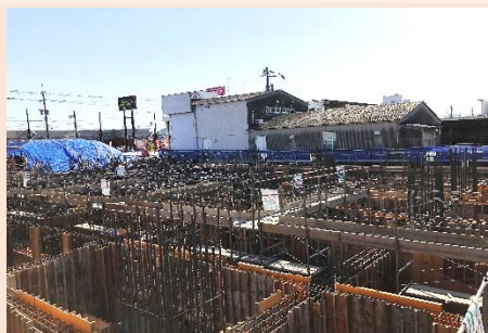
3月 基礎鉄筋型枠組立
